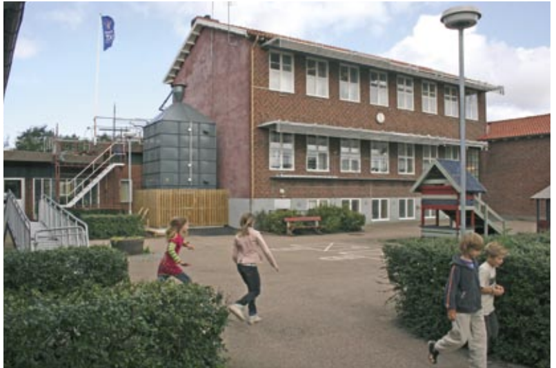
MAFA Modulsilo Außen mit Farbanstrich (34 m 3 ), Schule Eldsberga.
