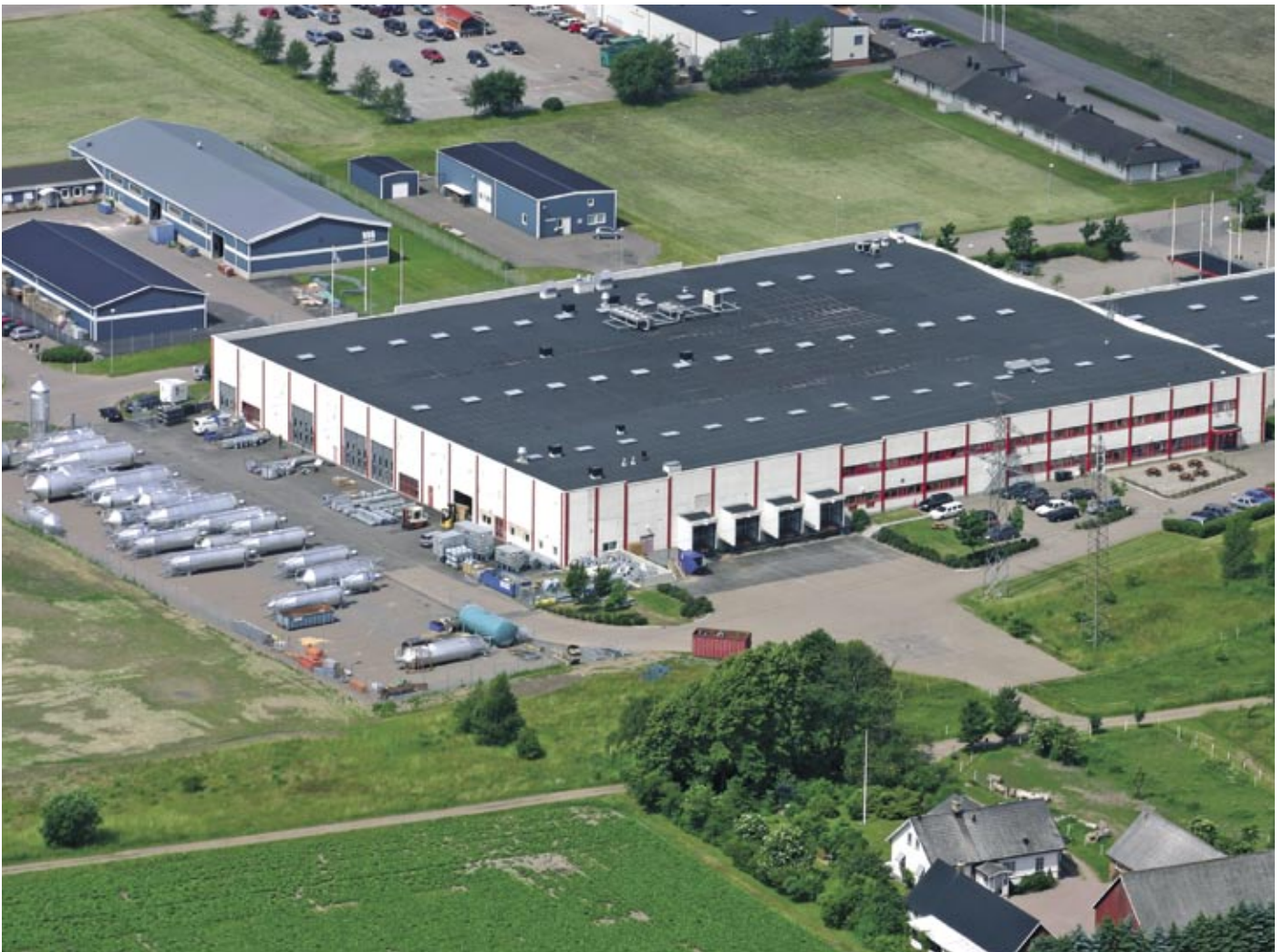
Der Hauptsitz von MAFA und die moderne Produktionsanlage befinden sich in Ängelholm, in Nordwest-Skåne.
