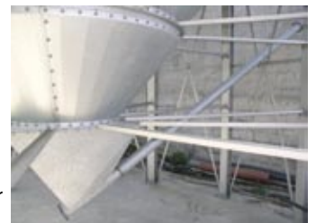
Robuste Befestigung der Stützbeine im Silo.
