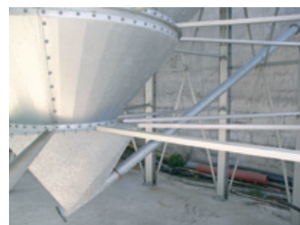
Kraftig infästning av ben i silon.
