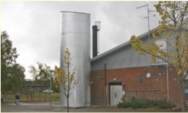
For bedre at kunne falde sammen med miljøet, kan MAFA's BIB siloer leveres med afdækning af konus og bund.
