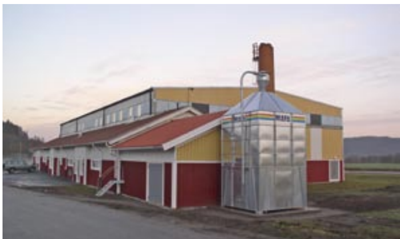
MAFA Utomhus Modulsilo (29m 3 ) vid Strömsholmskolan, Lilla Edet.
